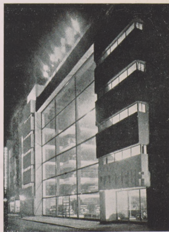
FIG. 36. - Dans le Garage Marbeuf on a réalisé une belle façade entièrement vitrée.
